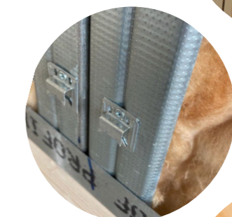
Montage an Trockenbauschiene mittels Montagekralle
